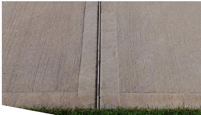
TripStop MC série S, montré ci-dessus tel qu'installé entre les dalles d'un trottoir
